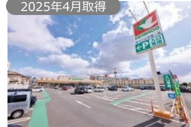
フレンドマート茨木平田店 (敷地)
