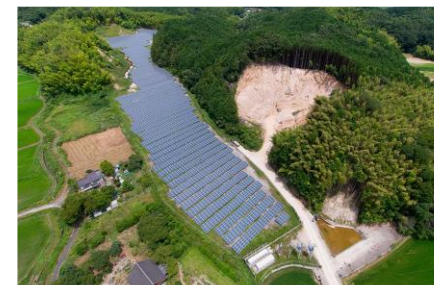
S-28 CS嘉麻市発電所 2.2MW
