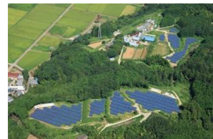
S-12 CS函南町発電所 1.3MW
