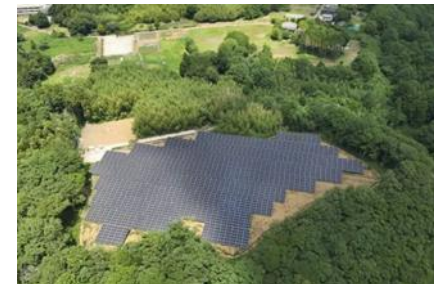
S-32 CS佐倉市発電所 1.2MW
