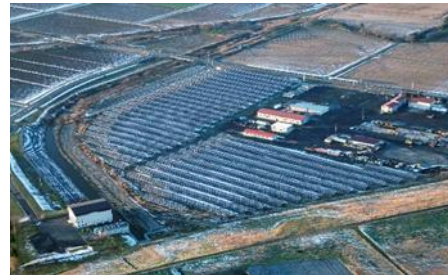
S-22 CS石狩新篠津村発電所 2.3MW
