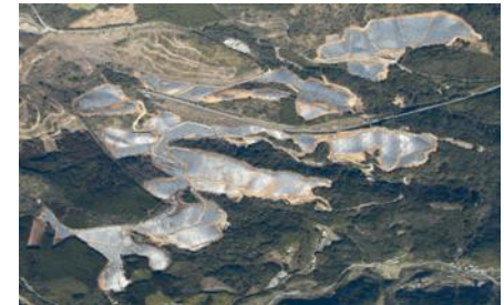
S-24 CS日出町第二発電所 53.4MW
