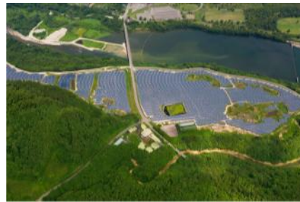
S-27 CS七ヶ宿町発電所 9.2MW
