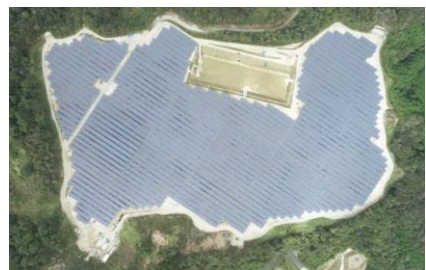
S-33 CS広島市鈴張発電所 17.5MW
