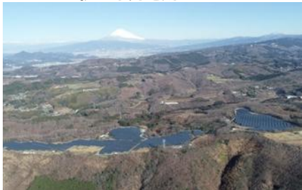
S-21 CS伊豆市発電所 10.7MW
