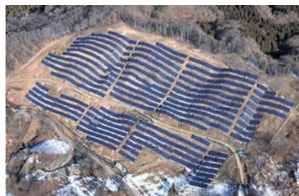
S-11 CS皆野町発電所 2.4MW
