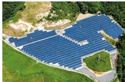
S-03 CS笠間市発電所 2.1MW
