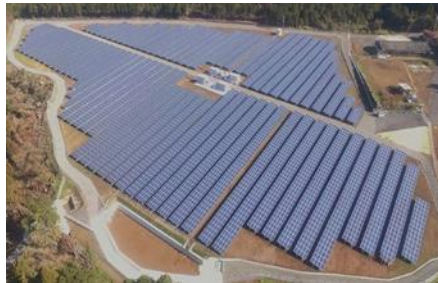
S-09 CS芦北町発電所 2.3MW
