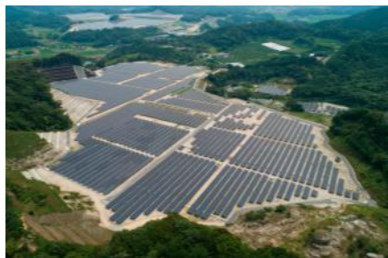
S-29 CSみやこ町犀川発電所 13.0MW
