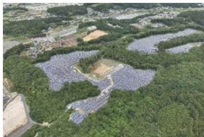
S-30 CS笠間市第三発電所 13.6MW
