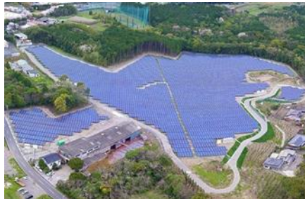
S-10 CS南島原市発電所(東) 同発電所(西)3.9MW
