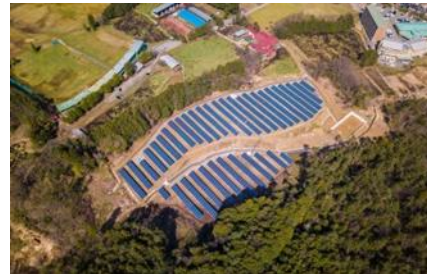
S-18 CS高山市発電所 1.0MW
