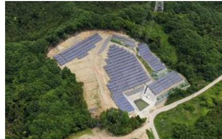
S-19 CS美里町発電所 1.1MW
