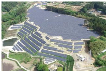
S-25 CS大河原町発電所 7.5MW
