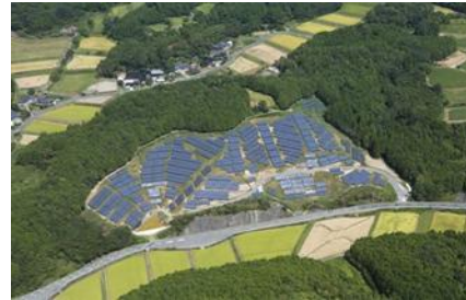
S-15 CS津山市発電所 2.0MW
