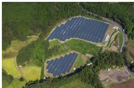
S-05 CS湧水町発電所 1.7MW
