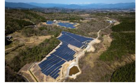
S-16 CS恵那市発電所 2.1MW
