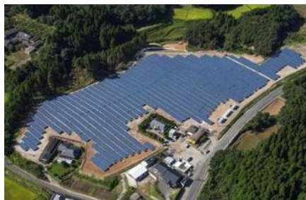
S-06 CS伊佐市第三発電所 2.2MW
