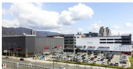
ブルメールHAT神戸 (兵庫県神戸市)
