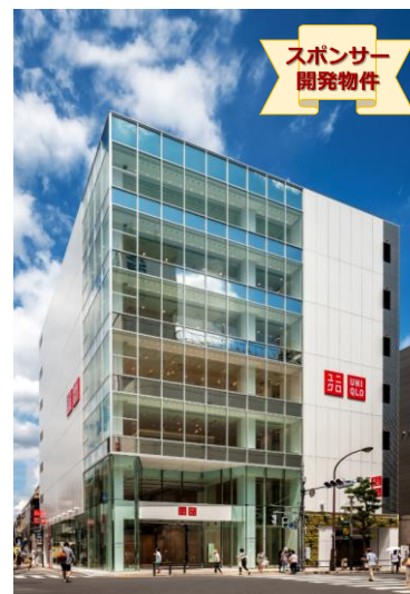
野村不動産吉祥寺ビル (東京都武蔵野市)
