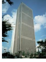
事A-14 新宿センタービル
