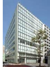
事A-20 JPR日本橋堀留ビル
