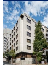
事A-4 新麹町ビル
