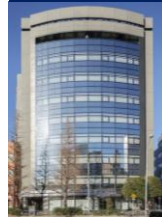
事A-15 南麻布ビル
