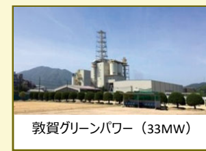
バイオマス 発電所
