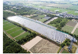
S-09 石川内灘太陽光発電所
