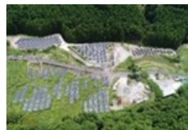
S-16 和歌山高田太陽光発電所
