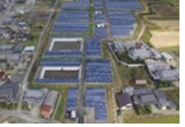
S-18 兵庫多可太陽光発電所
