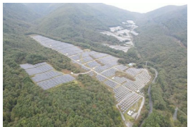
S-41 岩手五葉山太陽光発電所
