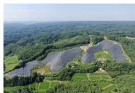
S-46 青森南部町太陽光発電所
