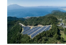
S-20 鹿児島霧島太陽光発電所
