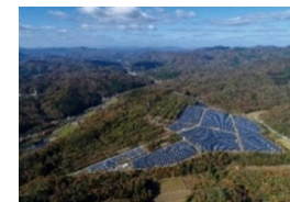
S-25 京都京丹波太陽光発電所
