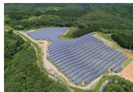
S-03 石川花見月太陽光発電所
