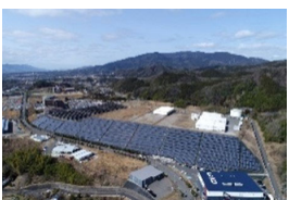
S-27 和歌山橋本太陽光発電所
