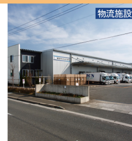
鳥栖ロジスティクスセンター
