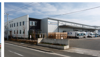
鳥栖ロジスティクスセンター
