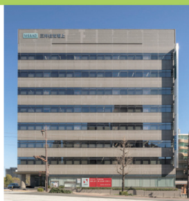
熊本イーストフロントビル
