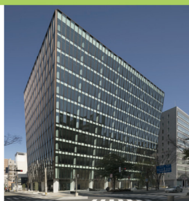
博多FDビジネスセンター
