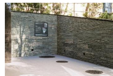
マンホールトイレ
