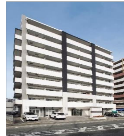
バネフィス博多南グランスウィート (福岡県福岡市)
