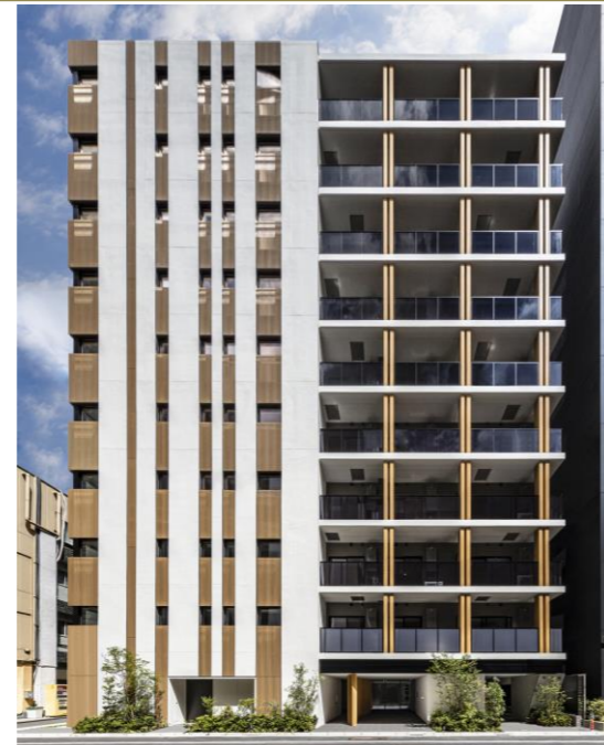
PM日本橋馬喰町(東京都中央区)
