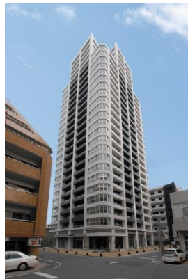
KDXレジデンス大濠ハーバービュータワー （福岡県福岡市）
