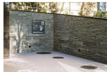
マンホールトイレ
