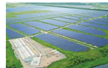
太陽光発電施設
