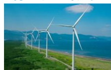
風力発電施設
