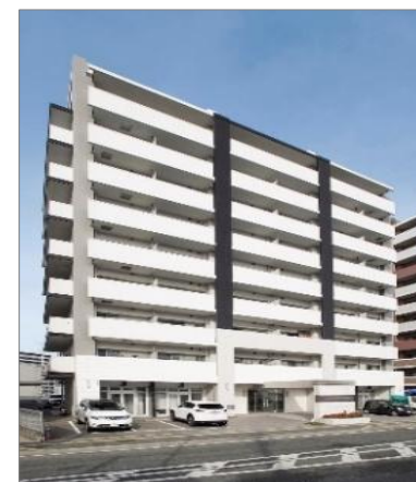
バネフィス博多南グランスウィート (福岡県福岡市)
