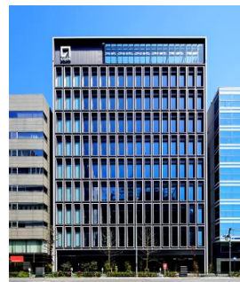
S-GATE大手町北
