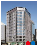
S-GATE 日本橋本町
