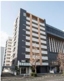
(福岡県) S-FORT筑紫通り
