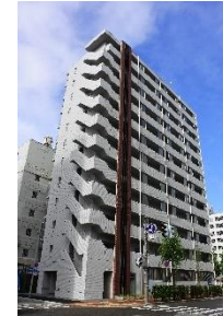
(新潟県) S-FORT新潟本町
