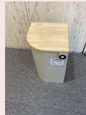
EV内 防災設備の設置 (池下ESビル)
