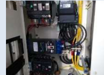
電子ブレーカー設置 (13物件導入済)
