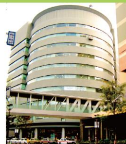
キャナルシティ・ ビジネスセンタービル
