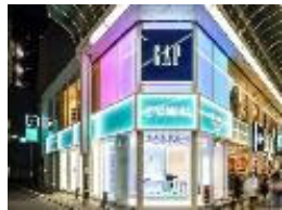
心斎橋MGビル
