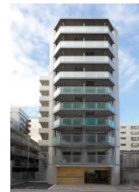
(神奈川県) S-RESIDENCE 横浜反町
