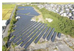
S-53 福岡鞍手太陽光発電所
