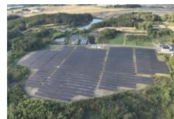
S-48 福島相馬1号太陽光発電所
