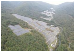
S-41 岩手五葉山太陽光発電所
