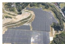
S-43 福岡熊ヶ畑1号・2号太陽光発電所
