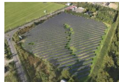
S-55 北海道中標津緑町太陽光発電所
