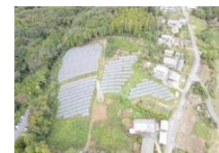
S-61 埼玉寄居太陽光発電所
