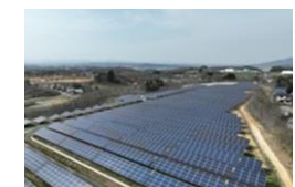
S-40 岩手一関太陽光発電所
