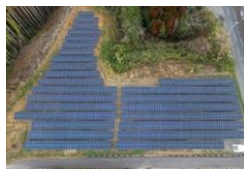
S-38 鹿児島日置2号太陽光発電所
