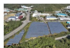
S-50 山形米沢太陽光発電所
