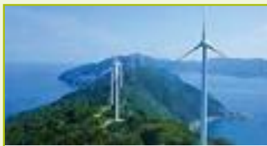
三崎ウインド・パワー (20MW)
