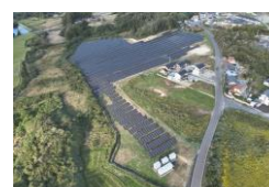
S-49 福島相馬2号太陽光発電所
