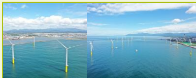
秋田港・能代港洋上風力 (139MW) (写真提供：秋田洋上風力発電株式会社)
