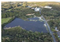
S-51 福島新地太陽光発電所
