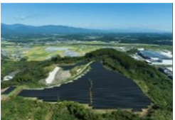
S-36 宮崎国富太陽光発電所
