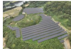
S-54 福島本宮太陽光発電所
