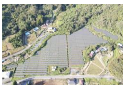
S-52 茨城桜川太陽光発電所
