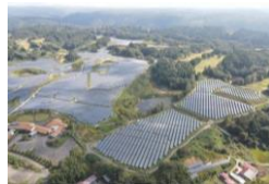
S-42 福島石川太陽光発電所
