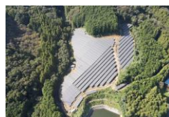
S-58 群馬高崎中里見太陽光発電所
