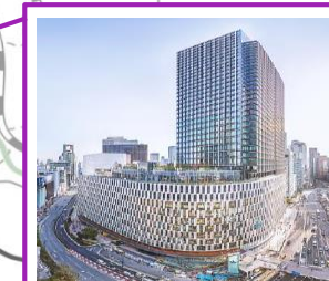
大阪梅田 ツインタワーズ・サウス
