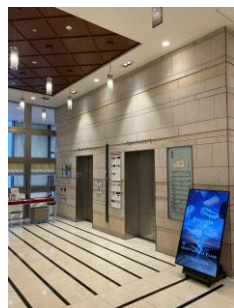
VIORO(LED化工事後)
