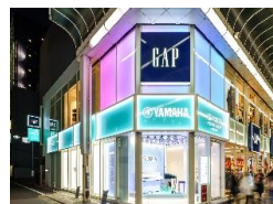
心斎橋MGビル
