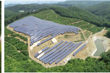
S-20 CS丸森町発電所 2.2MW
