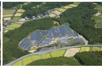
S-15 CS津山市発電所 2.0MW
