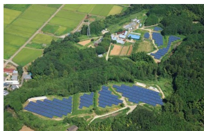
S-12 CS函南町発電所 1.3MW
