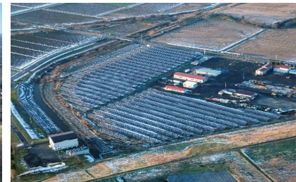
S-22 CS石狩新篠津村発電所 2.3MW
