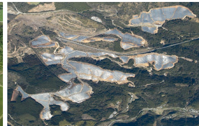
S-24 CS日出町第二発電所 53.4MW
