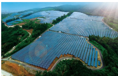
S-13 CS益城町発電所 47.7MW
