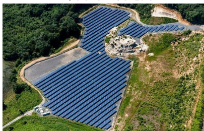
S-07 CS笠間市第二発電所 2.1MW
